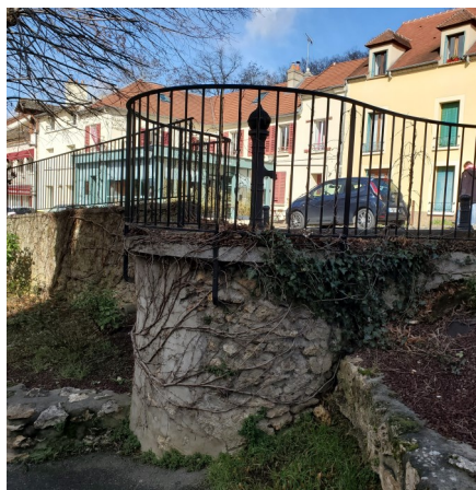
Sur l'ancien puits paroissial
